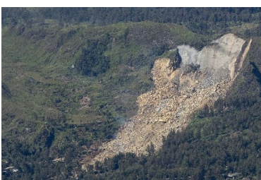
g. a landslide
